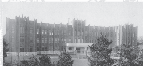
拓殖大学文京キャンパスA館 代表的な「復興建築」の一つ。 1932(昭和7)年1月竣工
